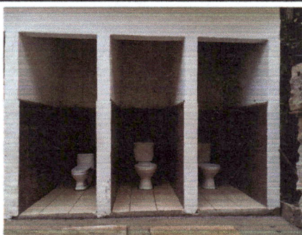
Foto 5: MODULO 4: SEGUIMIENTO DE MÓDULO DE BAÑO
