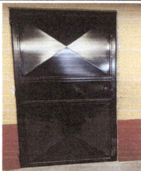
Foto 7: MODULO 6: SUSTITUCION DE PUERTAS DE METAL DAÑADAS
