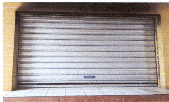
Foto 8: MODULO 7: SUSTITUCIÓN DE VENTANA DE METAL POR PERSIANA DE ALUMINIO.
