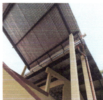
Foto 4: MODULO 3: SUSTITUCION DE CANAL DE METAL POR CANAL PLUVIAL DE PVC
