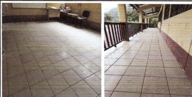
Foto 6: MODULO 6: REPARACION DE PISO DAÑADO Y COLOCACION DE PISO EN PATIOS DE EDIFICIO DE DOS NIVELES
