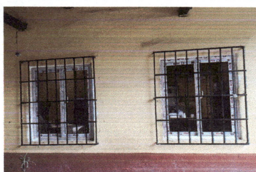
Foto 2: SUSTITUCION DE VENTANAS DE VIDRIO POR VENTANAS DE PVC
