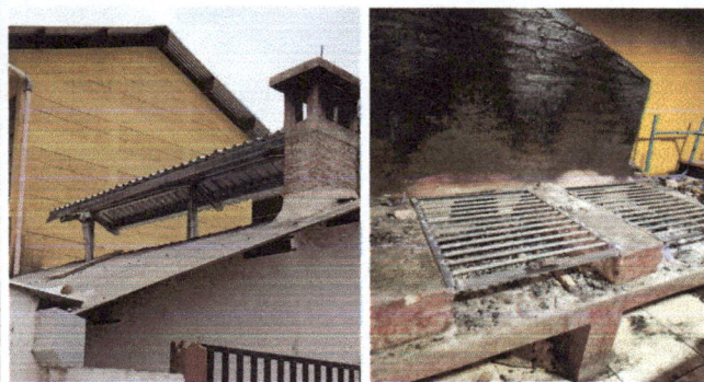
Foto 1: MODULO 1: MEJORAMIENTO DE LA SALIDA DE HUMO Y SUSTITUCION DE PARRILAS
